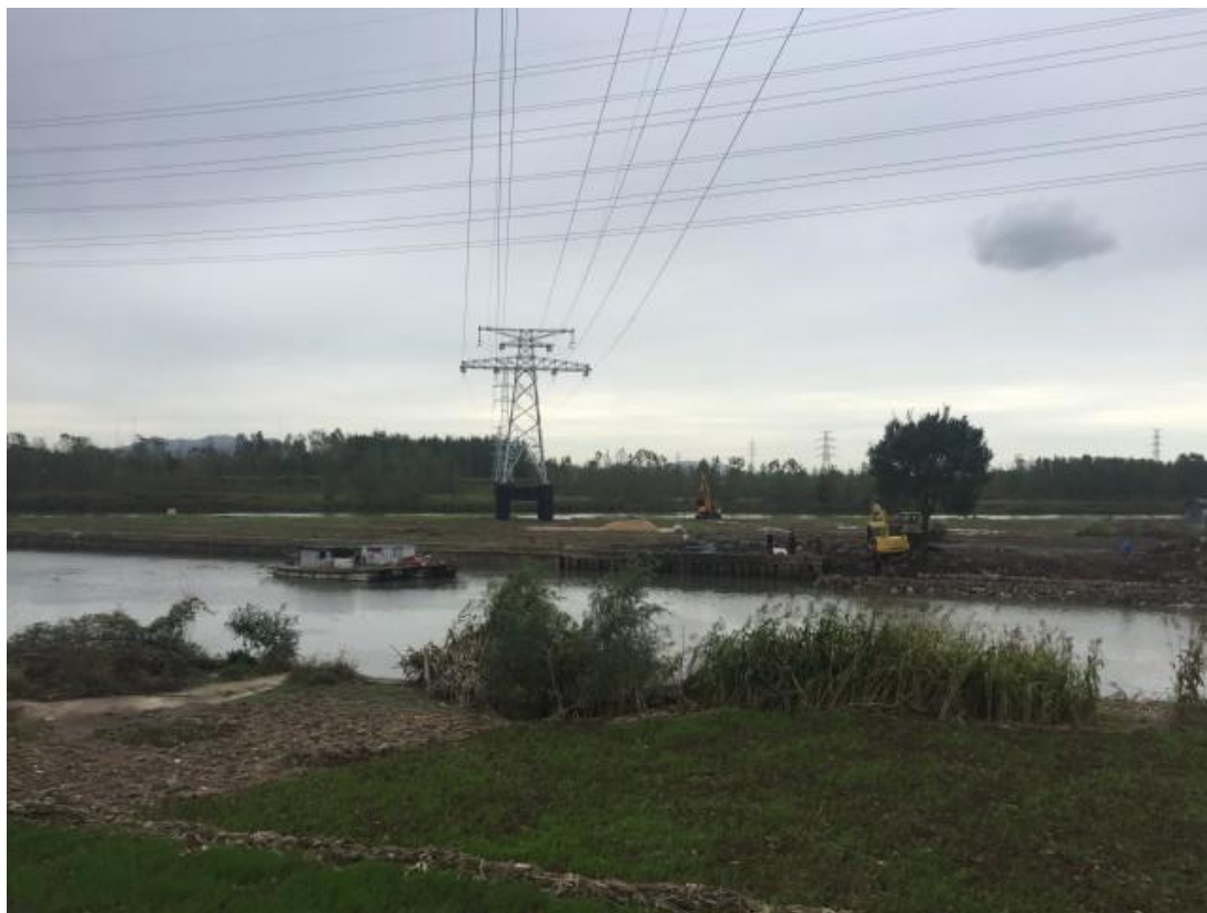
110kV 临洪变-银桥变线路工程在“临洪河重要湿地”二级管控区跨河照片
