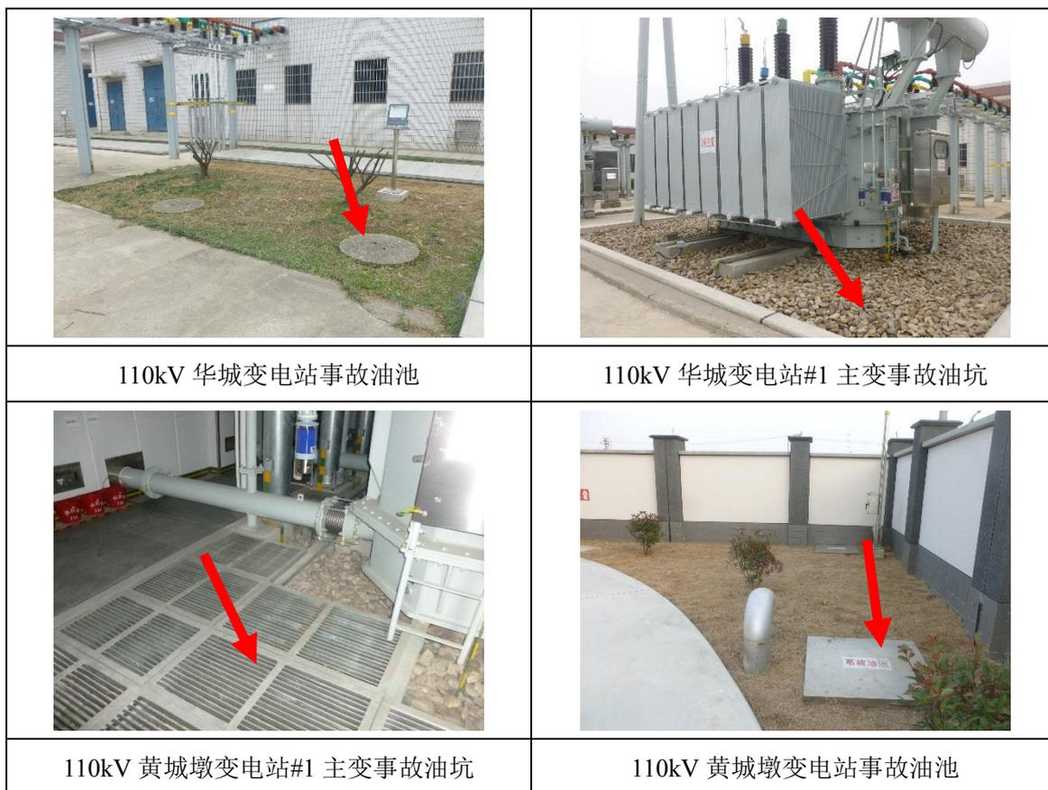
图 6-3 本批验收的变电站事故油池及事故油坑示例
