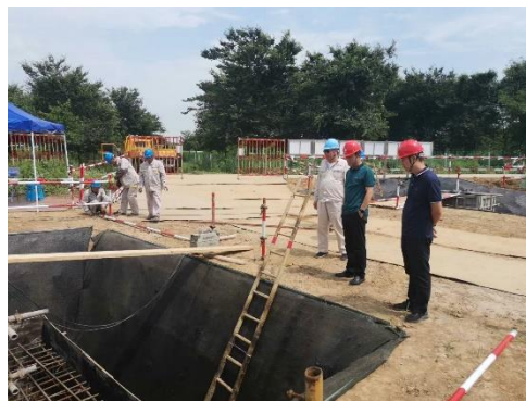
图6-2 施工场地设置泥浆池
