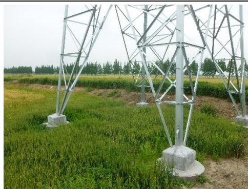
图 6-6 220kV 梦金 2924/梦金 2541 线#14 杆塔塔基周围生态恢复照片
