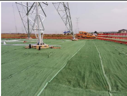
图6-3 施工现场塔基基础周围进行苫盖
