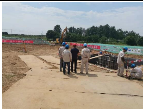
图6-4 施工场地铺设钢板
