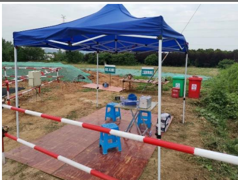
图6-5 施工场地设置围挡
