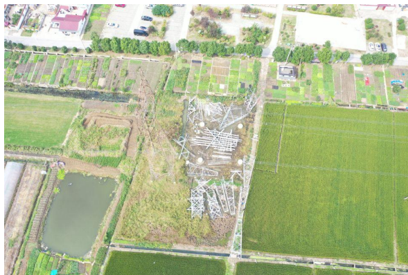
塔基及塔基施工区扰动面积图-9月
