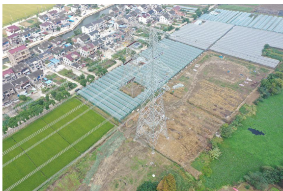
塔基及塔基施工区、牵张场区 3 处扰动面积图-9 月
