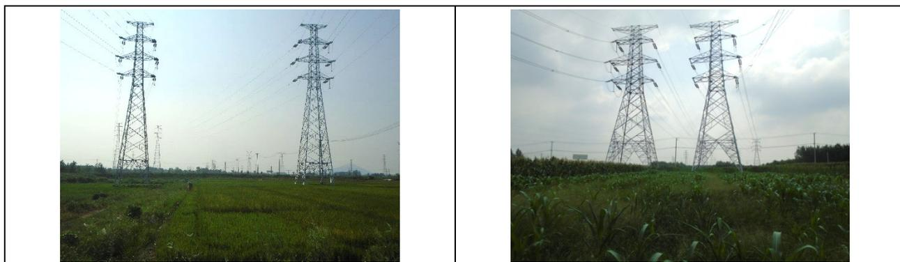
图 6-1 本期线路同塔双回架设照片
