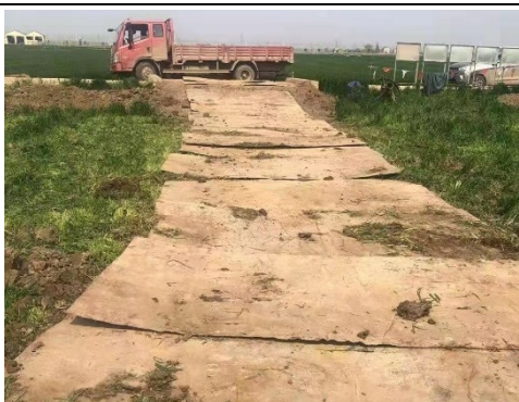
图 8-2 施工期临时道路铺设铁板照片
