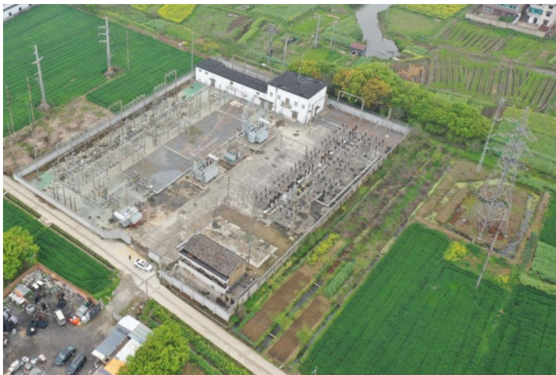
图 1.1-2 南渡 110kV 变电站及新建电缆处现状照片
