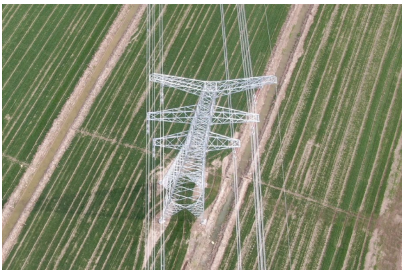
塔基及塔基施工区绿化(T17)6月
