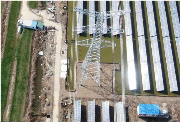
塔基及塔基施工区扰动面积图 (T4)6月
