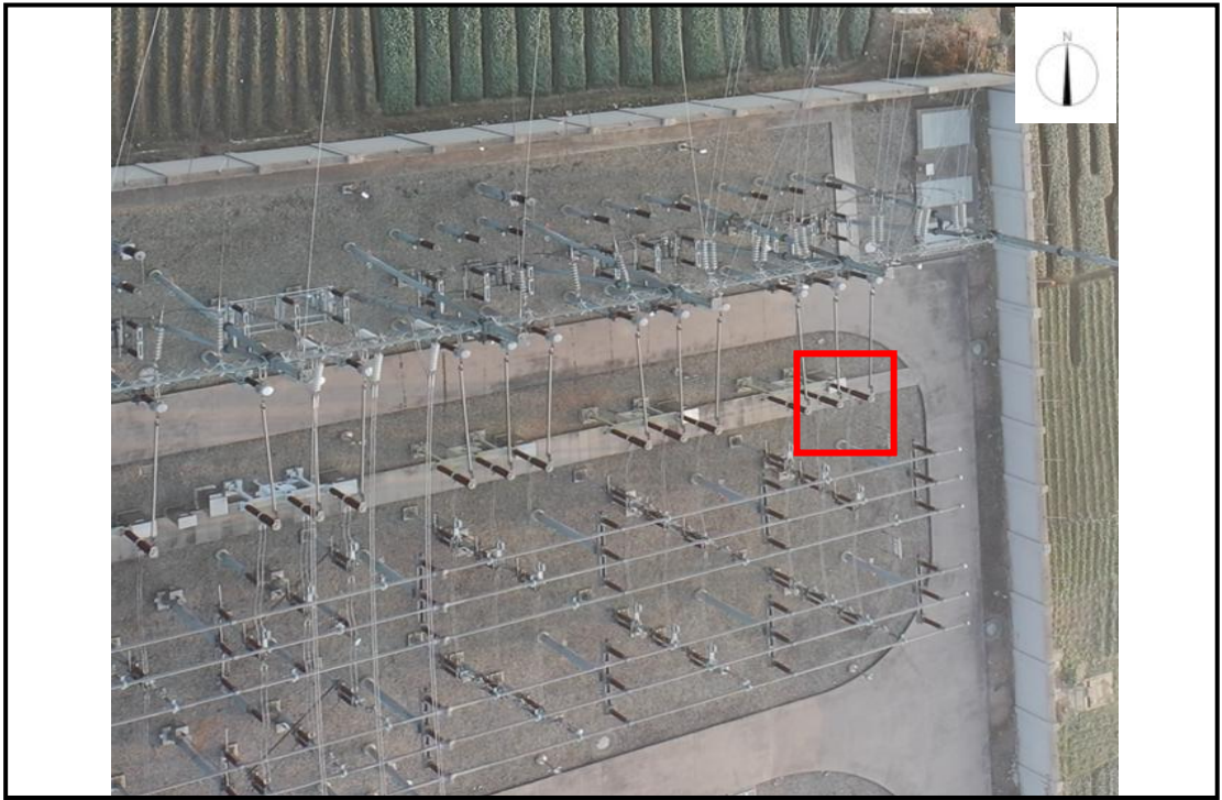
图 1.1-2 黄塍变 220 千伏变电站 110 千伏间隔改造工程现状照片（红框内为改造间隔） ②山阳~创能升压站 110 千伏线路工程
