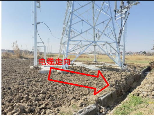
电缆管廊上方硬化、土地整治恢复示例
