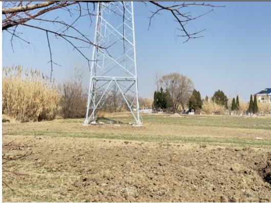
塔基占地复耕（110kV 麾龙 J04 线 T3 塔）
