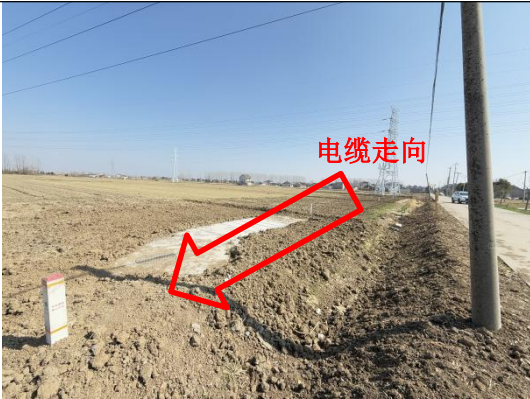
电缆管廊上方硬化、土地整治恢复示例
