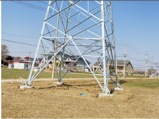
塔基占地复耕（110kV 麾龙 J04 线 T2 塔）
