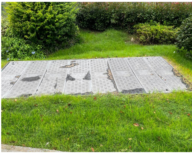
电缆线路生态恢复
