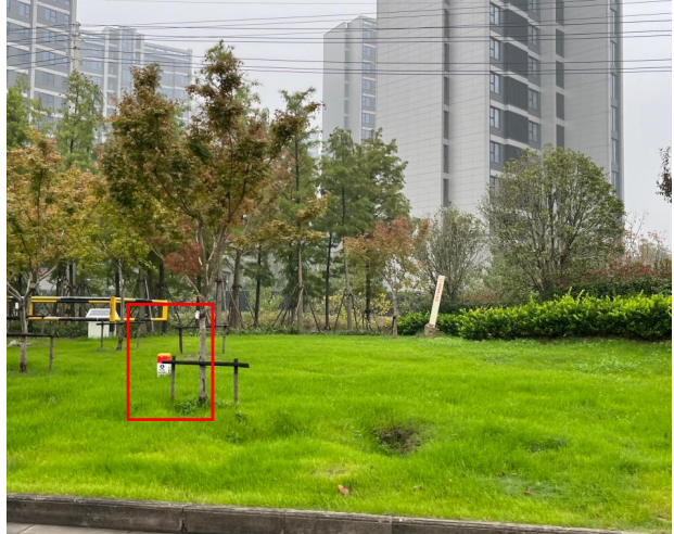
电缆线路警示标识及生态恢复
