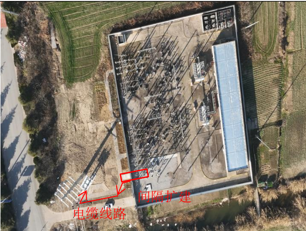
110kV 团结变电站间隔扩建生态恢复示例
