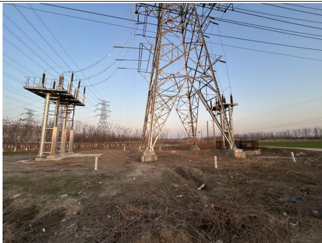
塔基生态恢复示例（110kV 垦阿 82A#1 杆塔）
