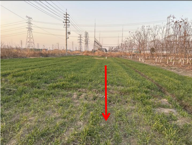
电缆上方恢复示例
