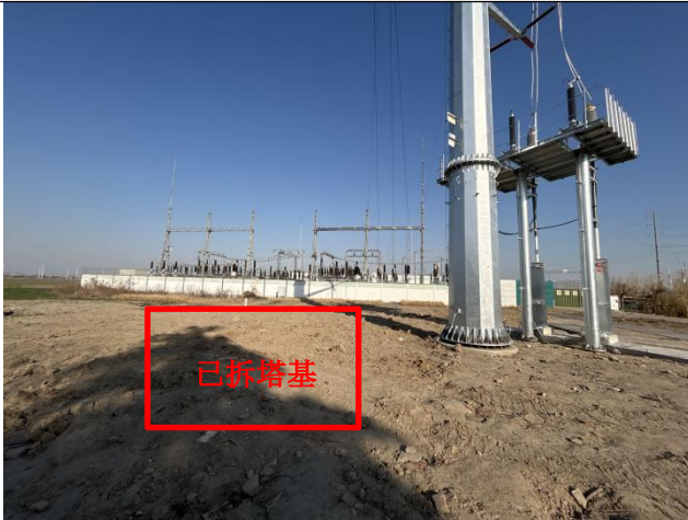
塔基生态恢复示例（拆除塔基 110kV 团阿 8L3#1 杆塔）
