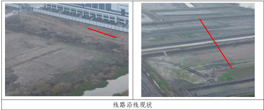
图 1.1-4 本工程现状照片
